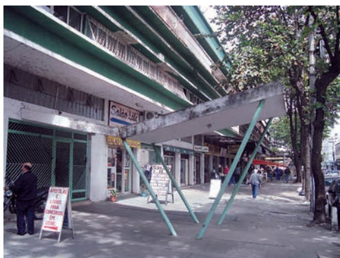
Edifícios Bandeirantes e Minas Gerais
